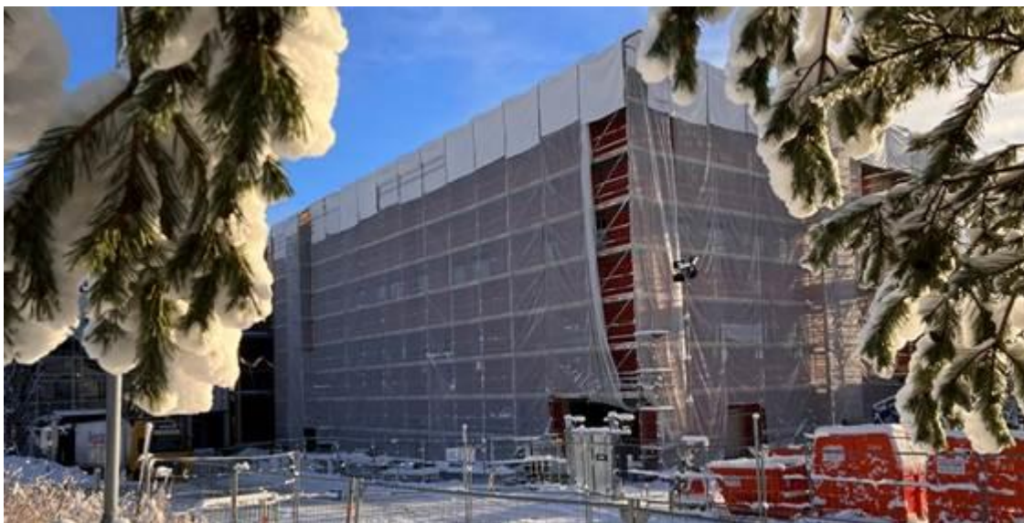
Nytt AIO-bygg, november 2025
