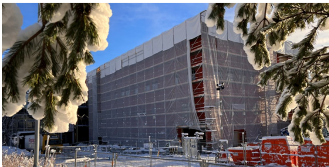
Nytt AIO-bygg, november 2025
