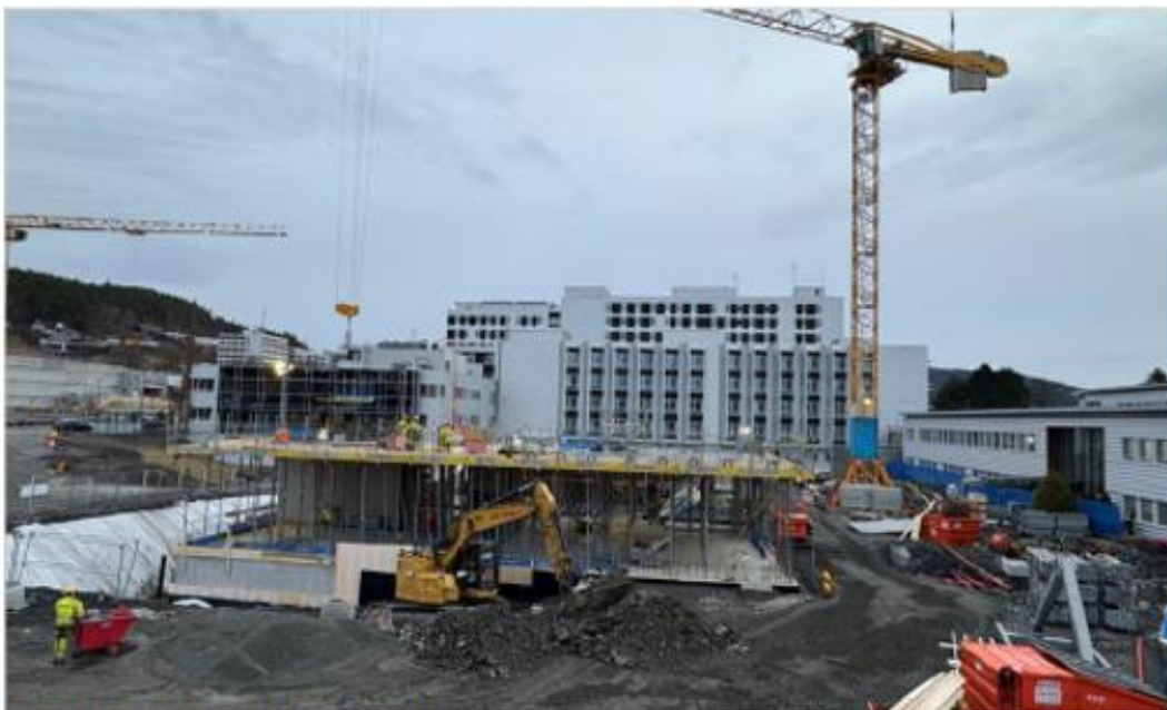
Byggeplass - nytt bygg AIO januar 2025
