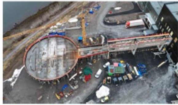
Bygging av helipad, januar 2025
